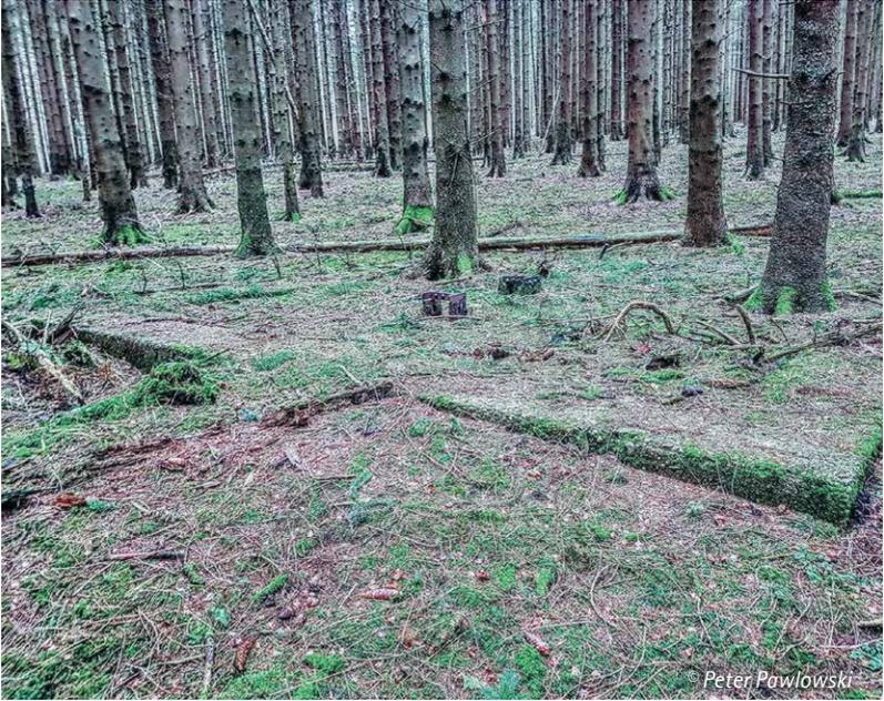
*Am Hevearm: Betonfundament der Seilwinde zum Halten und Spannen des Luftabwehrnetzes*
