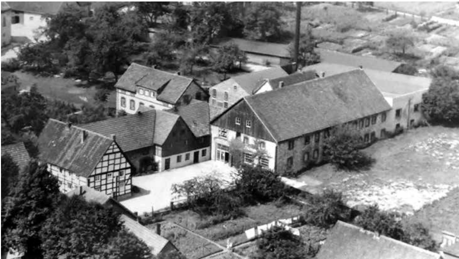
Haus Stockebrand mit Nebengebäuden um 1948
